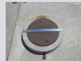
マンホールの固定【6,7号機】
