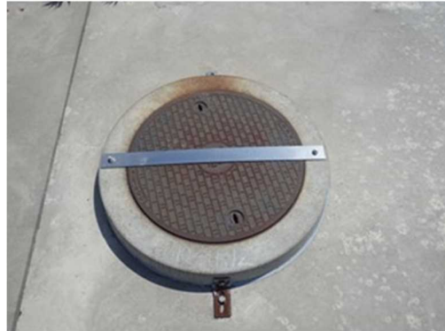
マンホール蓋の固定
