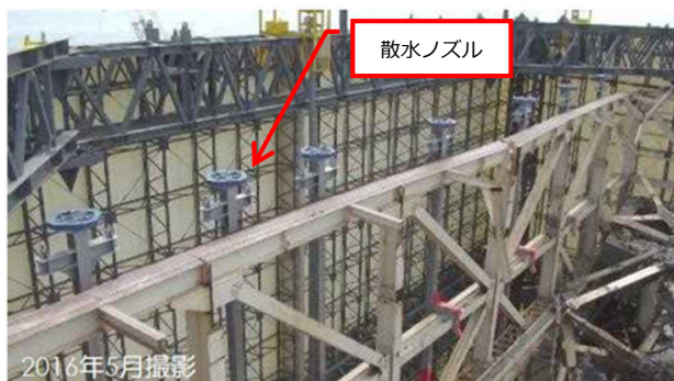
散水設備ノズルユニット設置状況
