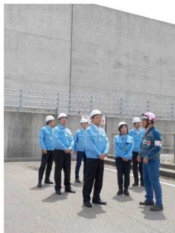
柏崎刈羽の視察（防潮堤）
