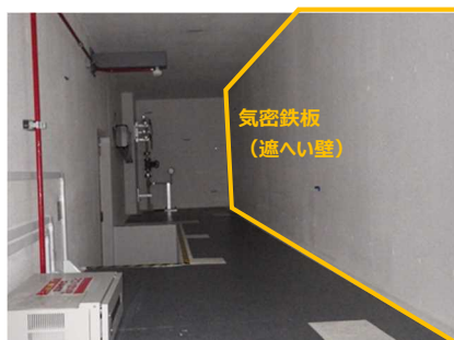
遮へい壁の設置（左：施工後写真、右：中央制御室退避室平面図）
