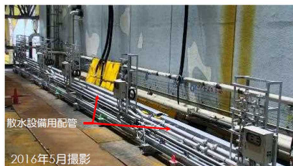
散水設備配管設置状況
