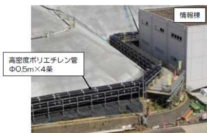
北側ルート配管状況（図：写真②）
