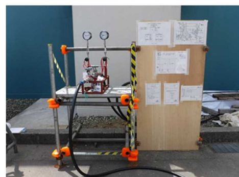
配管の耐圧試験（6号機）
