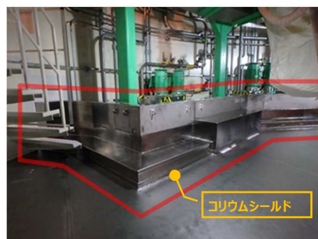
コリウムシールドの設置 (7号機)
