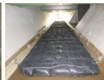
K排水路清掃及び浄化材設置状況
