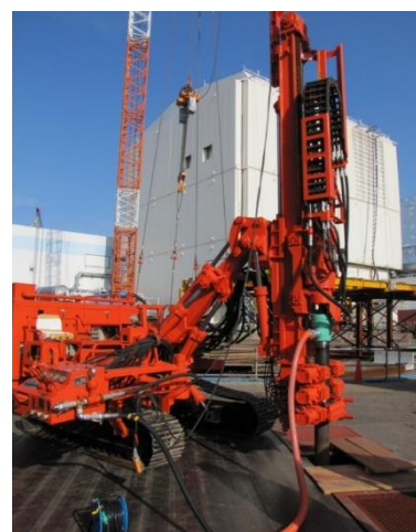
凍結管設置状況
