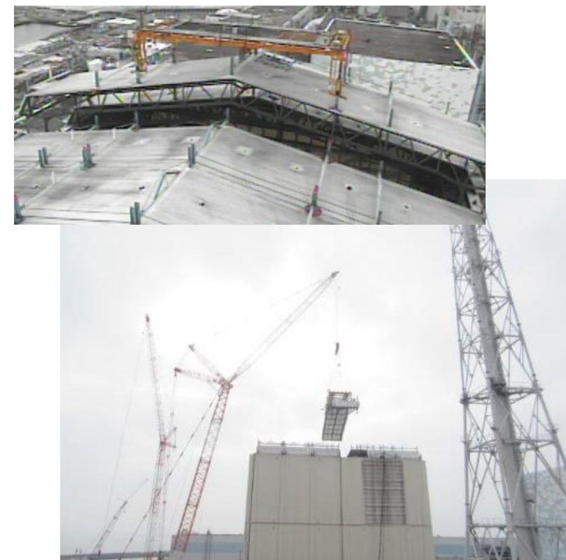
屋根パネルの取り外し状況
