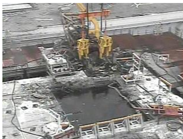
燃料交換機撤去状況
