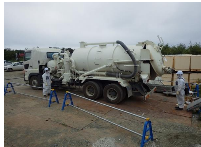
タンク蓋操作時の人員配置状況
