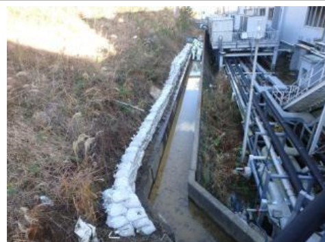
K排水路に流入する側溝清掃状況
