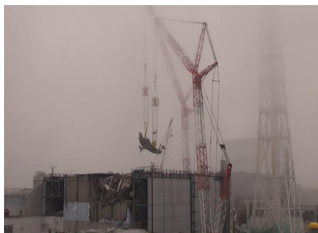
燃料交換機撤去状況
