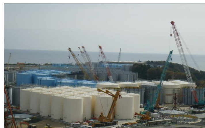
タンク建設・撤去進捗状況
