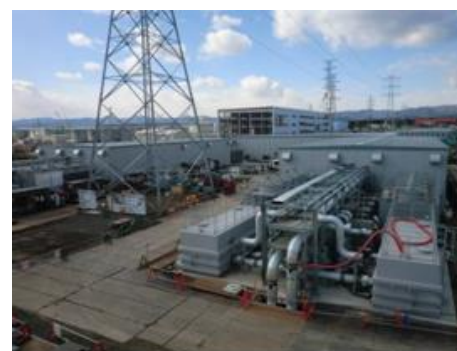
冷凍プラント建屋
