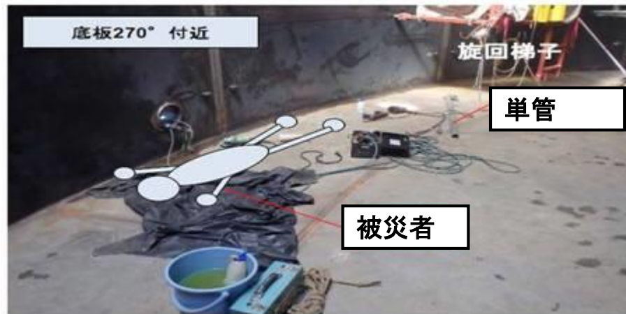
H26.11.7 旋回梯子レールが落下し負傷
