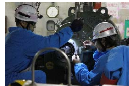
✓ 冷却水ポンプ復旧訓練
