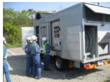
✓ 電源車接続訓練
