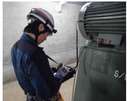
運転員の直営によるデータ採取（電動機の振動診断）
