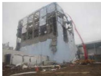
事故対応時に手配したコンクリートポンプ車による注水（4号機）
