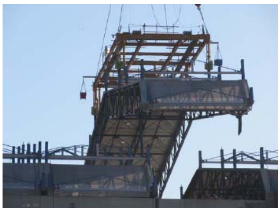
1号機建屋カバー屋根 パネル取り外し状況
