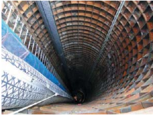
深さ約 30m の断層調査用立坑
