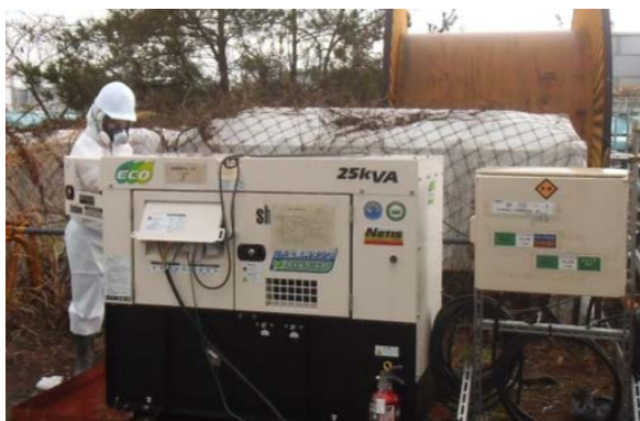
仮設発電機の接続・作動訓練（福島第一）
