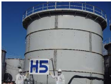
タンクエリアの識別表示板（福島第一）
