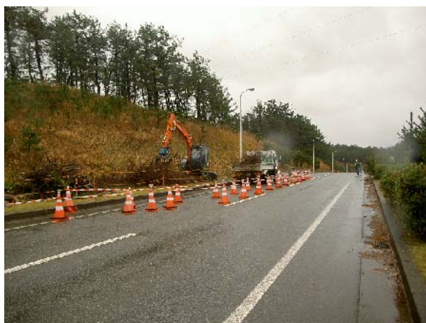
防火帯設置作業
