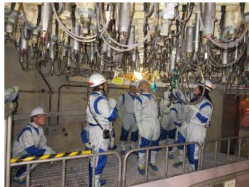
原子炉下部（ペDESTル）の確認（4号機）
