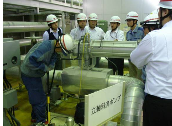
直営力情報共有会議における柏崎刈羽の改善事例の共有 (左：操作用空気喪失時の弁開閉ツール、右：ツールを用いた空気作動弁の開閉実演)
