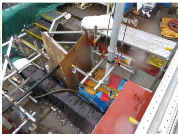
2号機海水配管トレンチトンネル部 における閉塞充填作業
