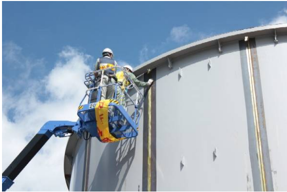
タンク溶接箇所確認作業
