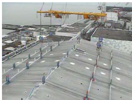
調査後の屋根パネル 取り付け状況
