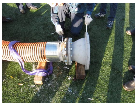
福島第一における仮設ホース（カナフレックス）接続訓練 （左：ホース同士の接続、右：異径フランジとの接続）
