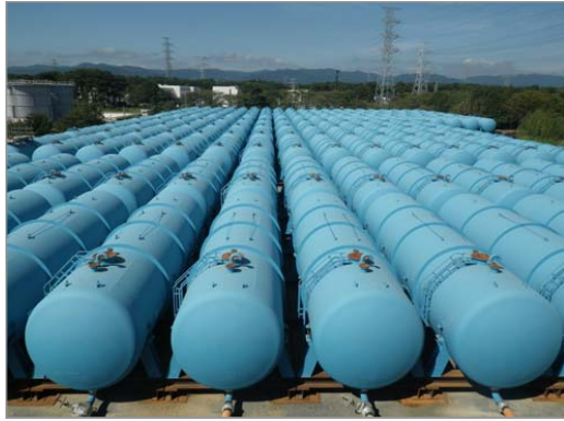
改善状況①：H1 エリアにおける 改善前のタンク設置状況
