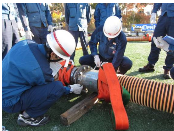
福島第一における仮設ホース（カナフレックス）接続訓練 （左：ホース同士の接続、右：異径フランジとの接続）
