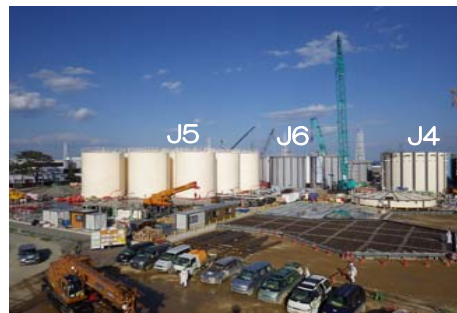
タンク建設状況
