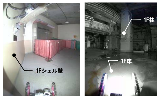
原子炉建屋躯体調査状況
