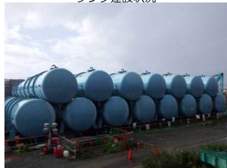
撤去タンク移設先保管状況
