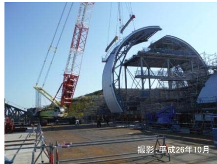
カバーの製作状況 (小名浜ヤード)
