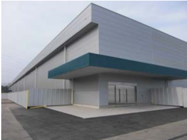
新事務棟外観
