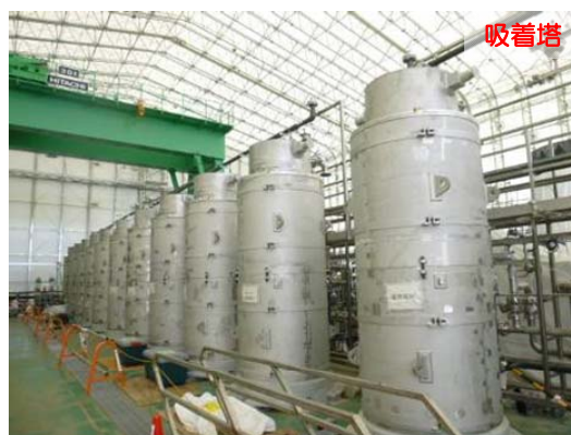
高性能多核種除去設備設置状況
