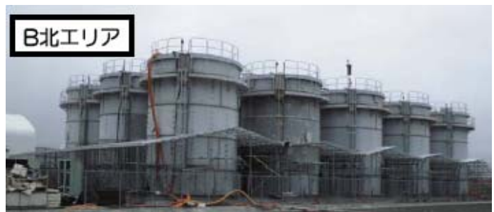
堰カバー（屋根材）設置状況
