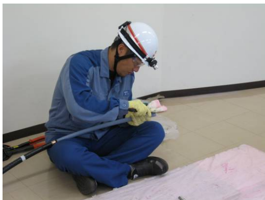
高圧ケーブル端末処理訓練
