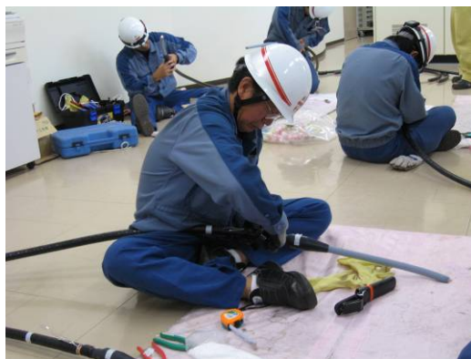
高圧ケーブル端末処理訓練
