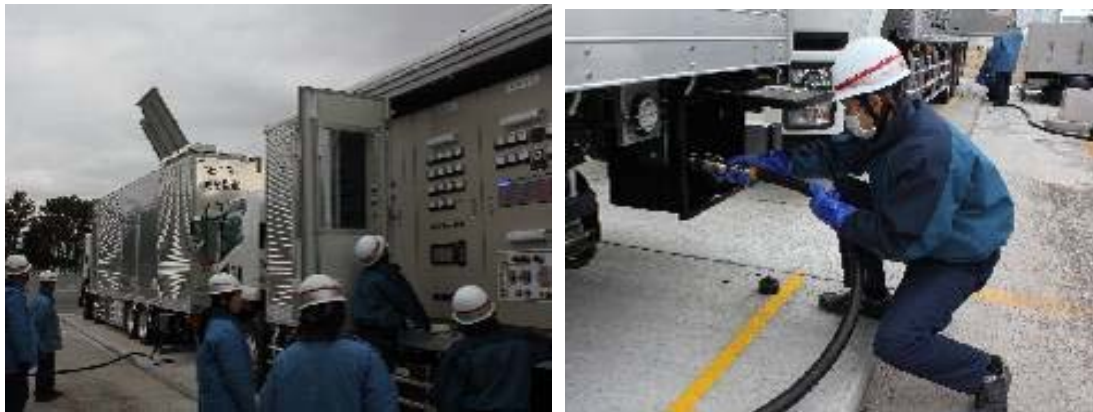
福島第二訓練風景（ガスタービン発電機車電源供給訓練）
