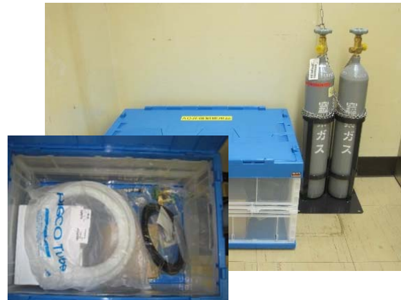
空気作動弁強制操作の資機材配備（福島第二） （圧縮空気ポンプ、接続用ホース、接続部品等）
