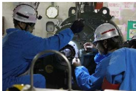
冷却水ポンプ復旧訓練 (軸受組立)
