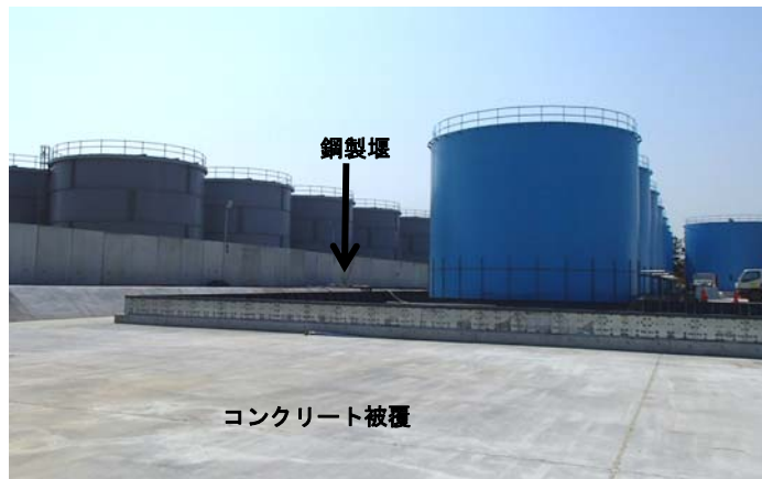
タンク堰二重化・堰内塗装工事状況
