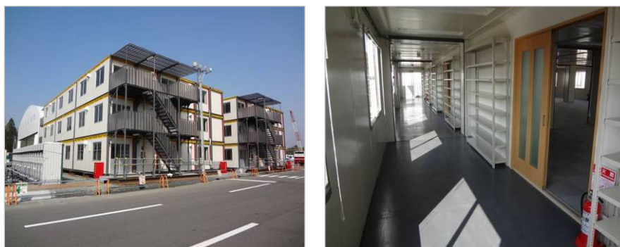
構外仮設休憩所（外観・内部）
