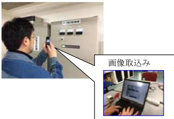
カメラ付 PHS の配備（福島第二） （撮影した写真を端末へ送付）
