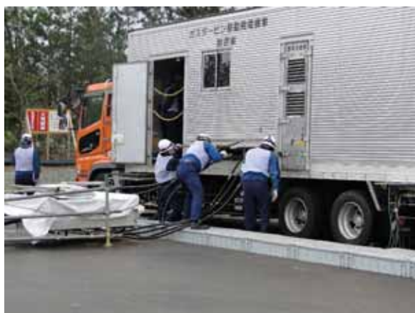
ガスタービン発電機車による 電源供給訓練風景
