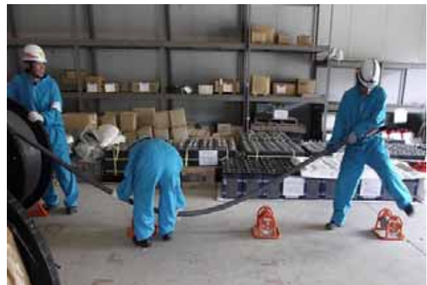
仮設ケーブル布設作業
