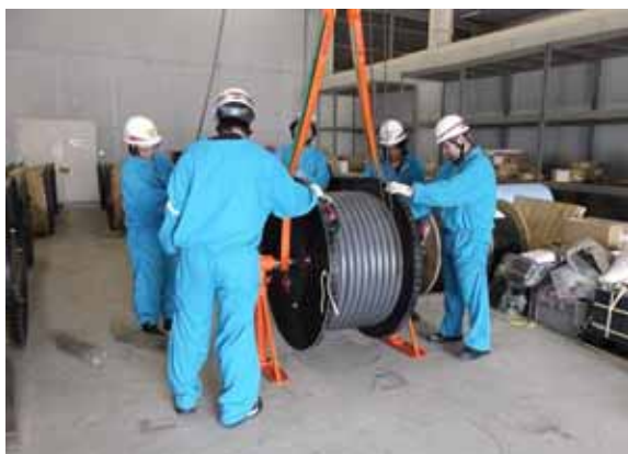
仮設ケーブル布設作業
