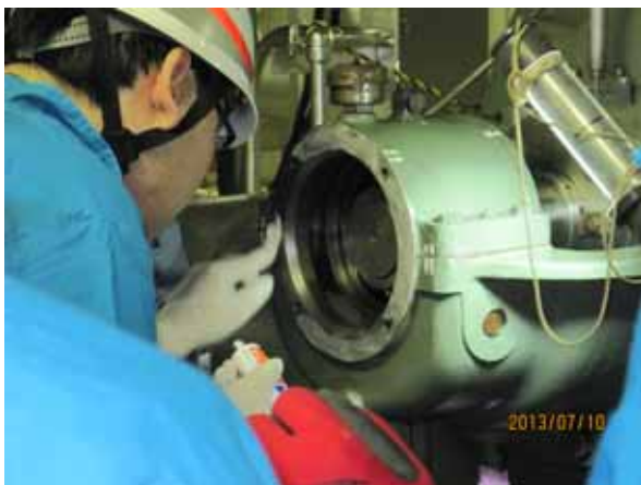
冷却ポンプ復旧作業
