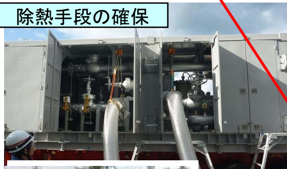
代替高圧注水設備設置
