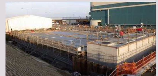
7号機 タービン建屋脇の基礎工事（コンクリート打設後）
