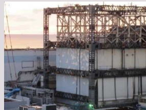
全壁パネル取り外し完了
