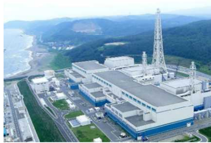
柏崎刈羽原子力発電所
