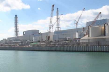
福島第一原子力発電所
