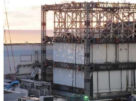
撤去完了 (2016年11月)
