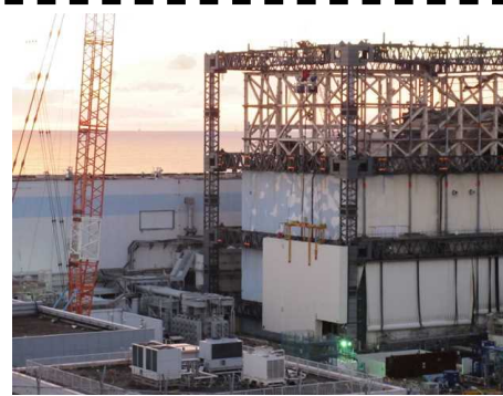
パネルの撤去 (2016年11月)
