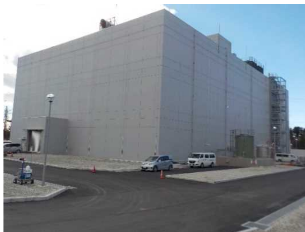
雑固体廃棄物焼却設備建屋
