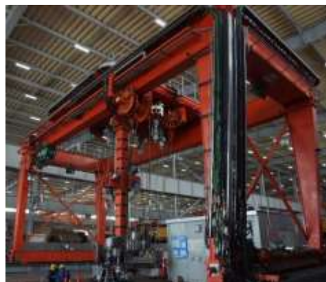
3号機 燃料取扱機
