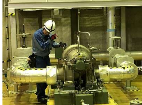
現場操作競技会（ポンプ起動確認）
