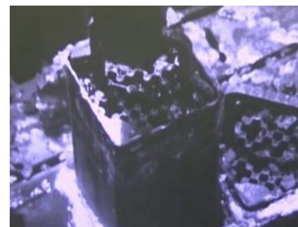
燃料の溶け落ちた炉で初めて、遠隔操作による使用済燃料プールからの燃料取り出しを開始（3号機）。
