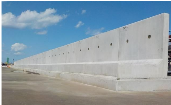
防潮堤設置状況
