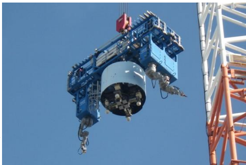
排気筒吊下ろし作業
