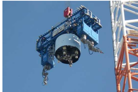
吊下ろし作業（2ブロック）
