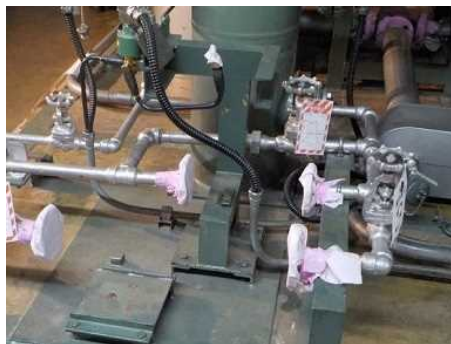
カイゼン前：不燃シートによる養生
