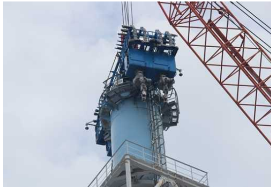
頂部ブロック切断作業
