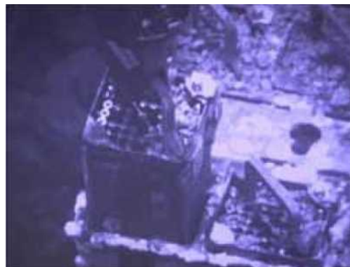
燃料取り出し作業
