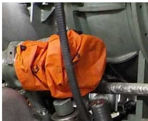
配管養生用カバー
