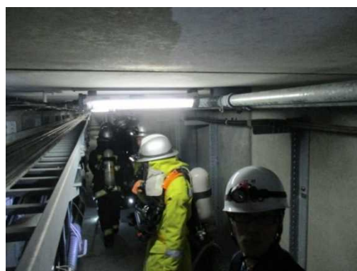
洞道内の火災現場確認
