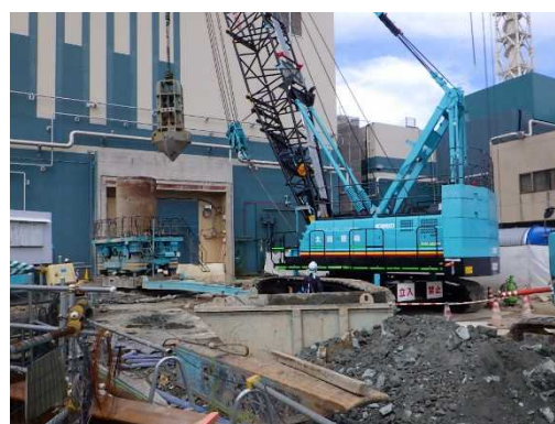
大物搬入口地盤改良
