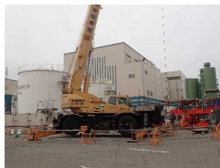
6号機軽油タンク
