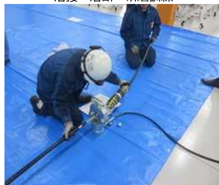
ケーブル端末処理・接続訓練
