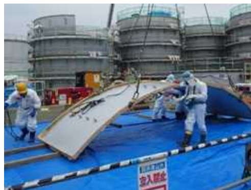
フランジタンク解体のカイゼン（福島第一） 左 タンク内部でのレーザー除染 右 タンク解体
