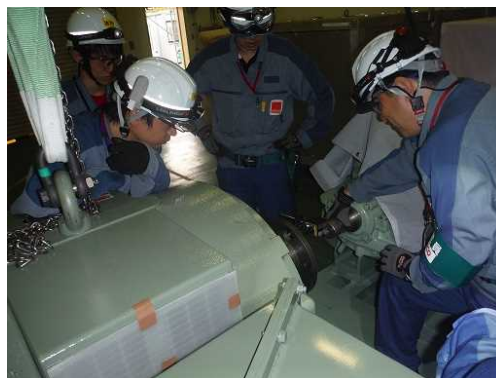
電動機取替訓練
