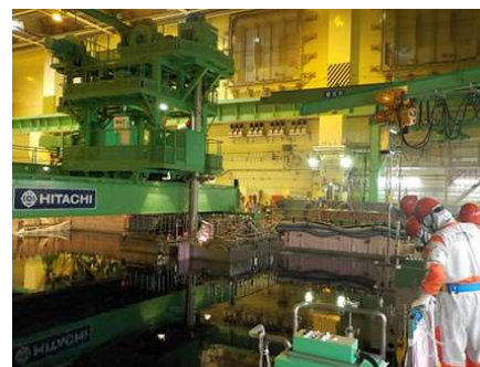
燃料洗浄作業（7号機）
