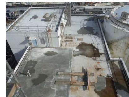
3/4号機増設サービスビル屋上
