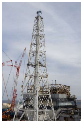
解体前の排気筒（2019年7月）
