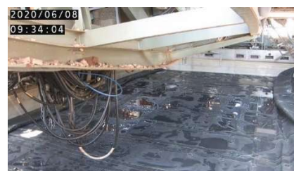
展張後の養生バッグ（6月8日）
