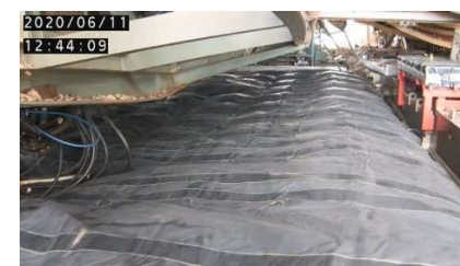
エアモルタル充填後（6月11日）
