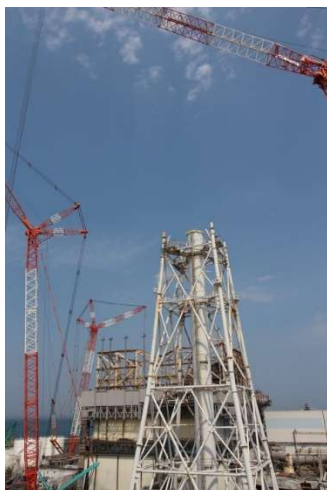
解体後の排気筒（2020年5月）
