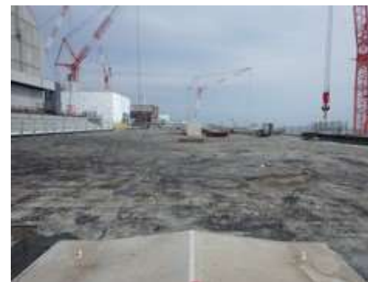
3号機タービン建屋屋上
