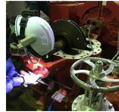
消火ポンプ復旧訓練（分解作業）
