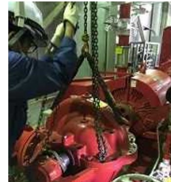
消火ポンプ復旧訓練（吊り上げ作業）
