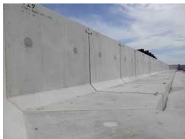
千島海溝津波防潮堤
