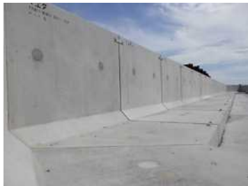
千島海溝津波防潮堤
