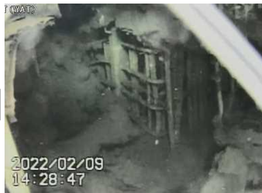
ペDESTAL開口部付近
