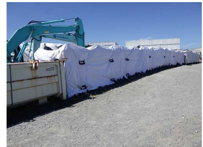
ノッチタンク仮設シート養生
