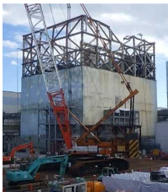
1号機原子炉建屋現場状況
