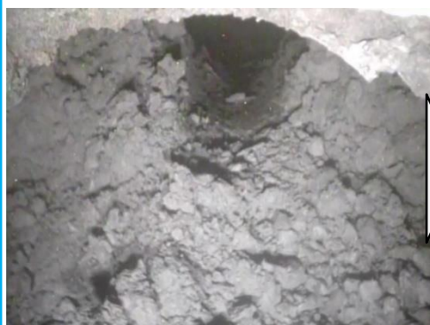
1月17日作業開始前 （低圧水施工前）
