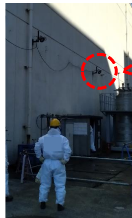
【現場状況（建屋外観）】
