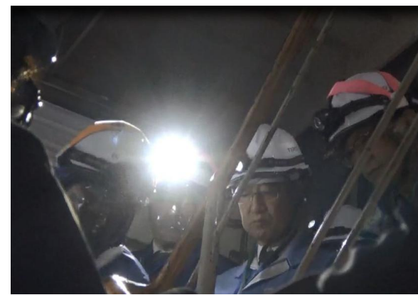
電源敷設訓練
