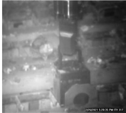
3号機での燃料の吊り上げ (566体目)
