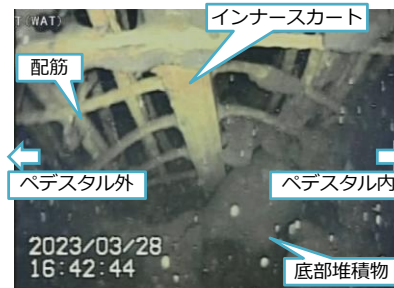
ベDESTAL開口部付近
