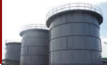
フランジ型タンク
