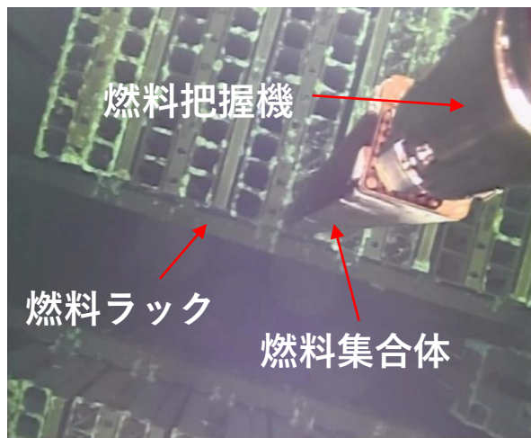
1体目の燃料をラックから持ち上げ始める様子（2026年6月2日）
